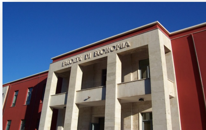
Palazzina di Economia nel campus universitario del Polo pontino della Sapienza in Viale XXIV Maggio, 7
